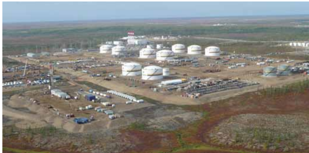
Ванкорское нефтегазовое месторождение. Резервуарный парк
