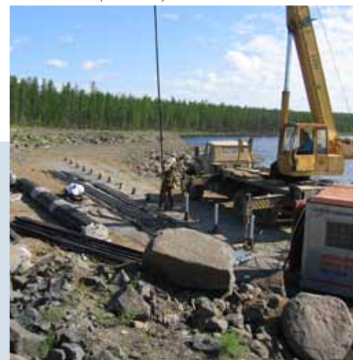
АК «Алроса» Нюрбинский ГОК. Плотина р. Лиендокит. Монтаж коллекторных СОУ
