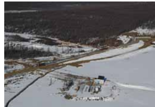
Плотина на реке Лиендокит. Система ВЕТ с аппаратами воздушного охлаждения.
