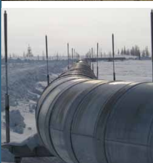
Нефтепровод «Ванкор-НПС Пуриле». Надземная прокладка с применением термостабилизаторов
