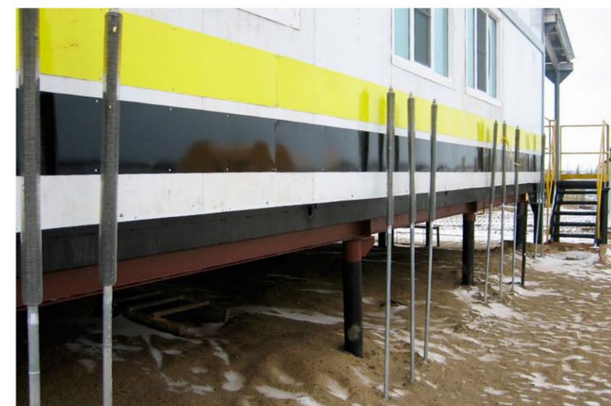
Кислородная станция 15 x 15 м. На переднем плане – термостабилизаторы.
