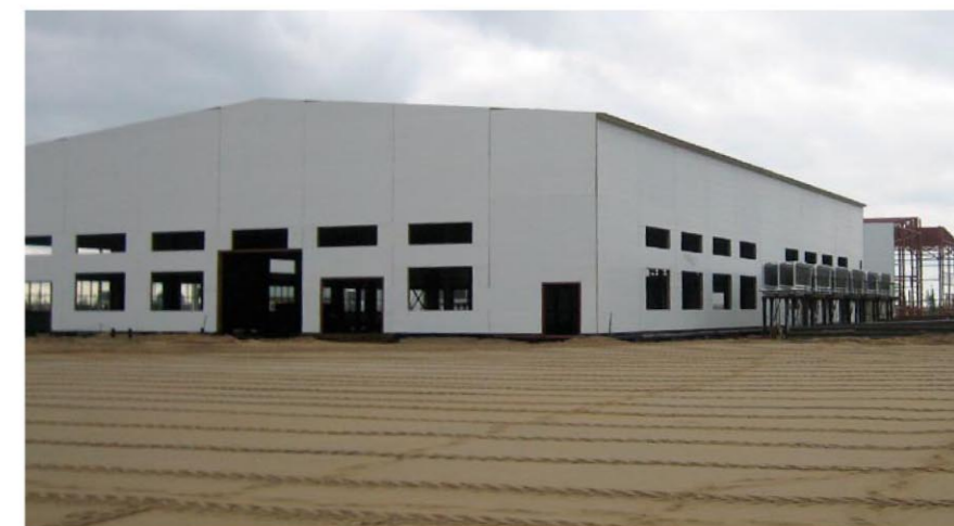
Производственный корпус по ремонту насосно-компрессорных труб 48 x 66 м. С правой стороны здания – конденсаторные блоки системы ГЕТ
