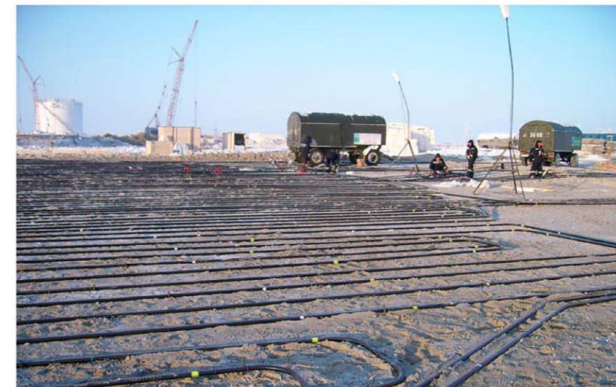
Монтаж охлаждающих труб системы «ГЕТ» под РВС 30 000.
