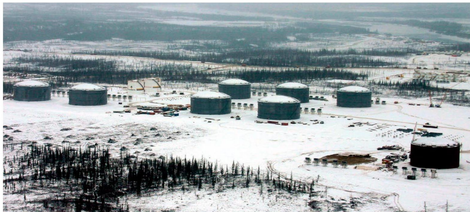
Резервуарный парк нефти на ЦПС 4 РВС 30 000, 5 РВС 20 000, 2 РВС 5 000, 2 РВС 2 000.
