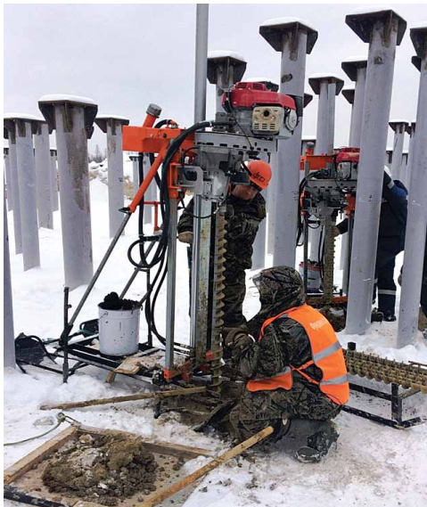
Бурение скважин под вертикальные охлаждающие трубы
