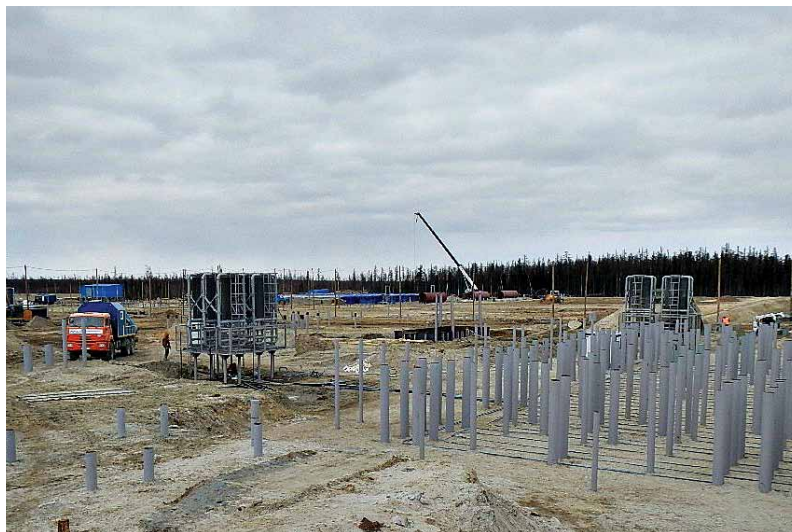
Смонтированные системы охлаждения, готовые к засыпке
