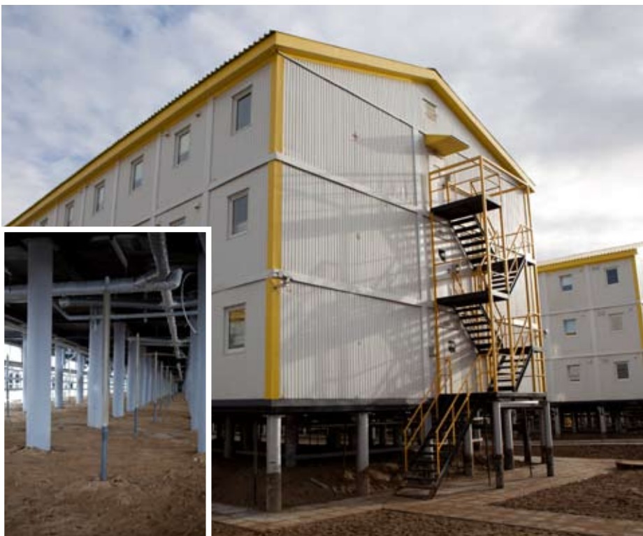
Индивидуальные термостабилизаторы в основании проветриваемого подполья
