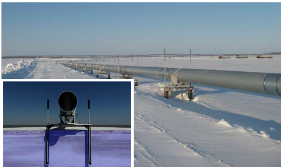
Нефтепровод Ванкор — Пурпе. Индивидуальные термостабилизаторы, установленные совместно со сваями
