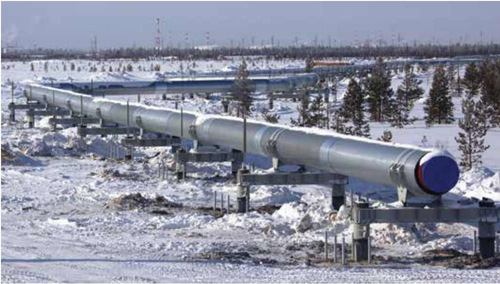
Термостабилизаторы, установленные совместно со сваями опор. Нефтепровод Заполярье – Пурпе
