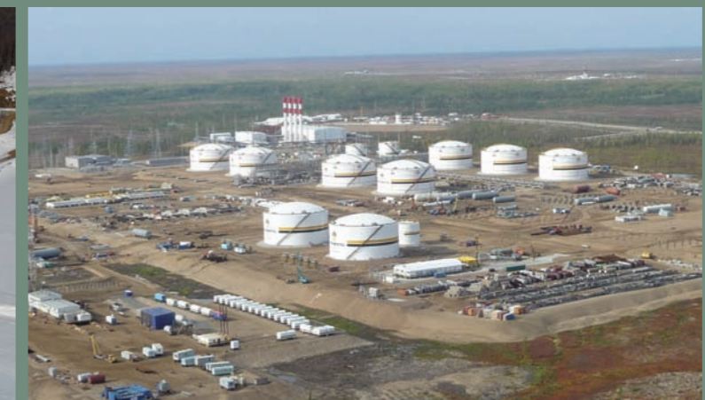
Ванкорское месторождение Резервуарный парк с системами «ГЕТ» в основании
