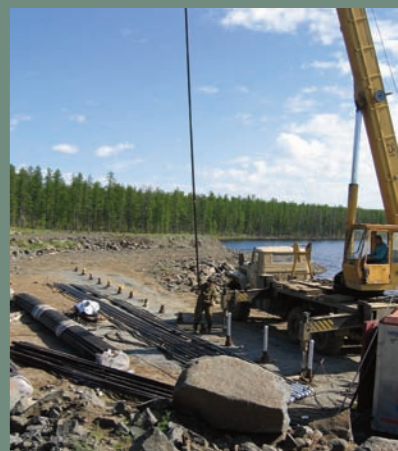
АК «Алроса» Монтаж глубинных термостабилизаторов
