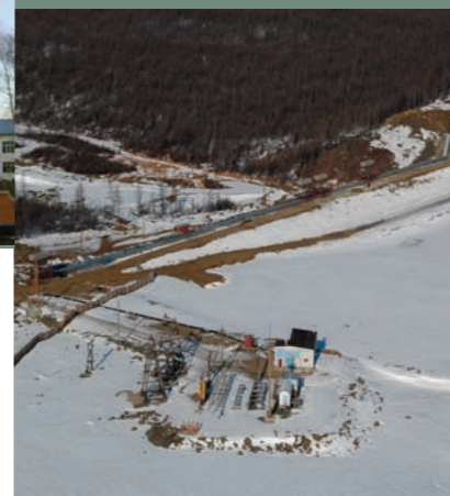
АК «Алроса» Нюрбинский ГОК Плотина на р. Лиендокит
