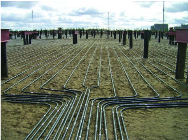
Термостабилизация системами ГЕТ в основании производственного корпуса (116,2 x 66 м) на Ванкорском нефтяном месторождении
