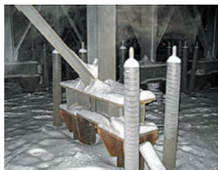
Рис. 6. Вполовину работающие термостабилизаторы, выявленные вследствие тепловизионного исследования. Причина – наличие инертных газов в хладагенте
