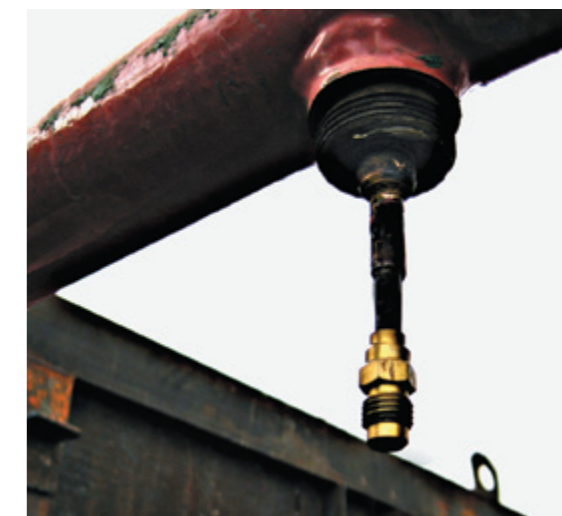
Рис. 5. При использовании клапанов Шредера колпачок должен привариваться. Резьба не дает долгосрочную абсолютную герметичность, что вызовет утечку хладагента
