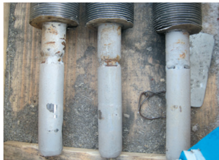
Рис. 2. Недопустимые дефекты покрытия корпуса термостабилизатора, наличие ржавчины
