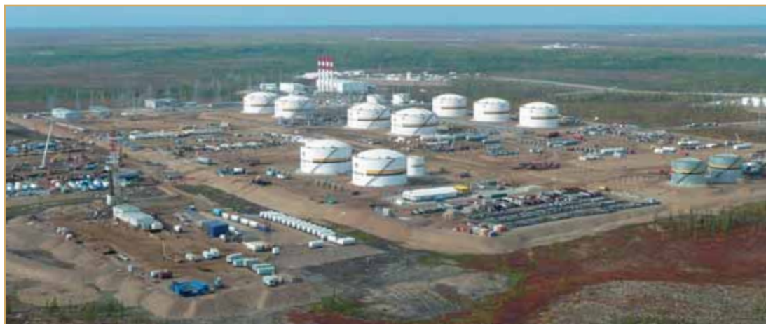
Резервуарный парк Ванкора построен на надежных фундаментах с термостабилизирующими системами ГЕТ в основании
