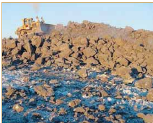
Рис. 7. Начало отсыпки площадки строительства зимой 2007/08 г.
