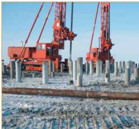
Рис. 11. Столбчатый фундамент. Свая с анкерной пятой
