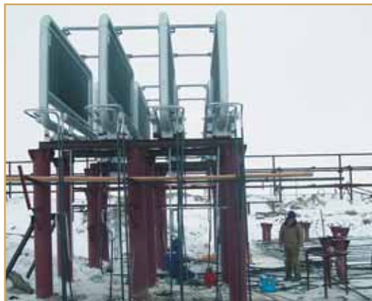
Рис. 6. Пример обустройства конденсаторных частей горизонтальной сезонноохлаждающей системы
