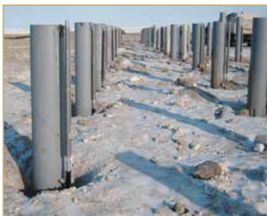
Рис. 8. Производство свайных работ и погружение охлаждающих систем летом 2009 г.
