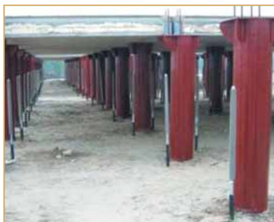
Рис. 9. Завершение работ по нулевому циклу в октябре 2009 г.
