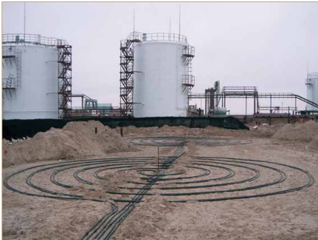
Рис. 4. Пример обустройства испарительной части горизонтальной сезонноохлаждающей системы
