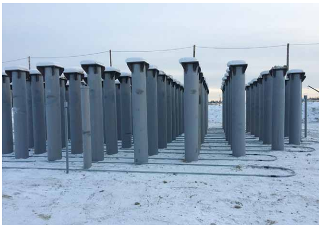
Рис. 2. Охлаждающая система «ГЕТ» в основании строящегося сооружения
