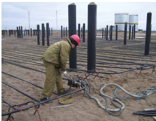
Рис. 4. Охлаждающая система «ГЕТ» в основании строящегося сооружения. Сварка труб на передвижной головке автоматической сварочной установки
