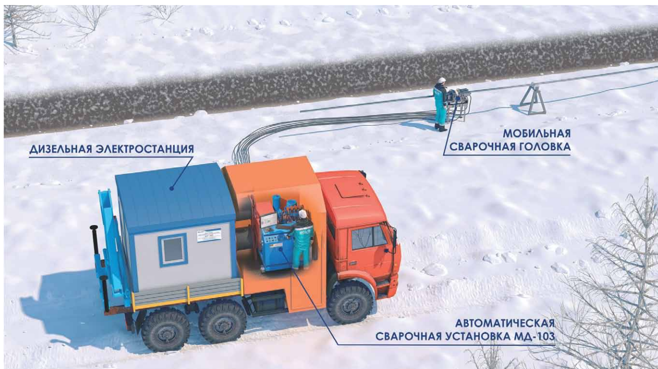
Рис. 1. Использование автоматической сварочной установки СПУ-89М для сварки труб метанопровода
